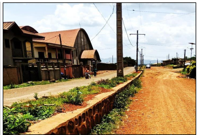
Photo 4 : Poteaux électriques en ciment
