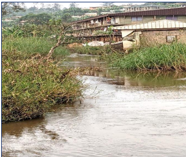
Photo 1 : Maison en bordure du cours d'eau de la régie de Dschang
