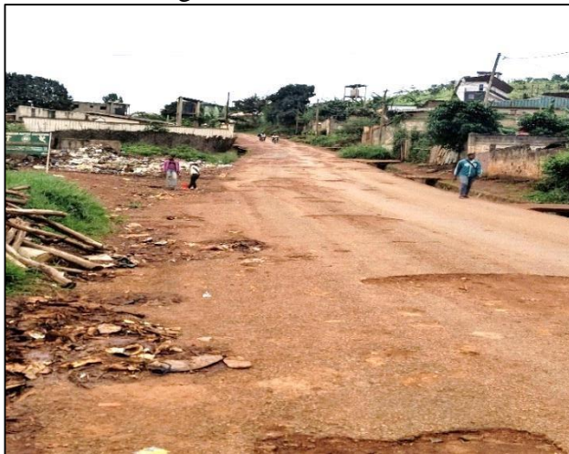
Photo 3 : Route bitumée dégradée sur les bordures totalement dégradées à Foéke
