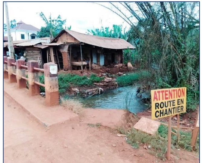
Photo 2 : Maison en bordure du cours d'eau de la régie de Dschang
