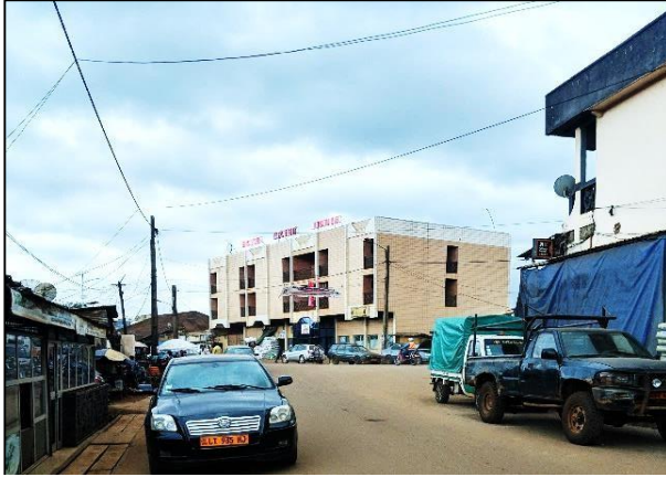
Photo 1 : Ligne électrique au centre-ville
