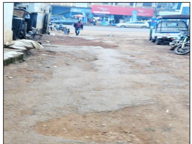
Photo 4 : Route bitumée dégradée sur les bordures totalement dégradées à Nkeleng
