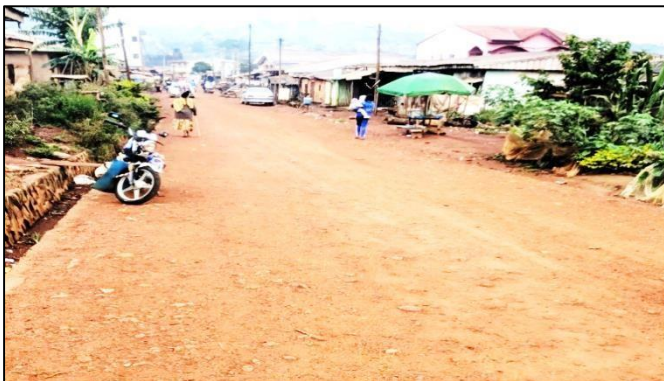
Photo 1 : Route en terre Dschang
