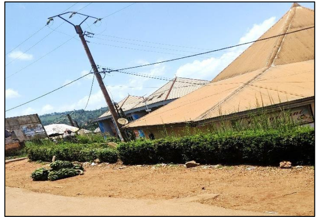
Photo 2 : Ligne électrique au musée de Dschang
