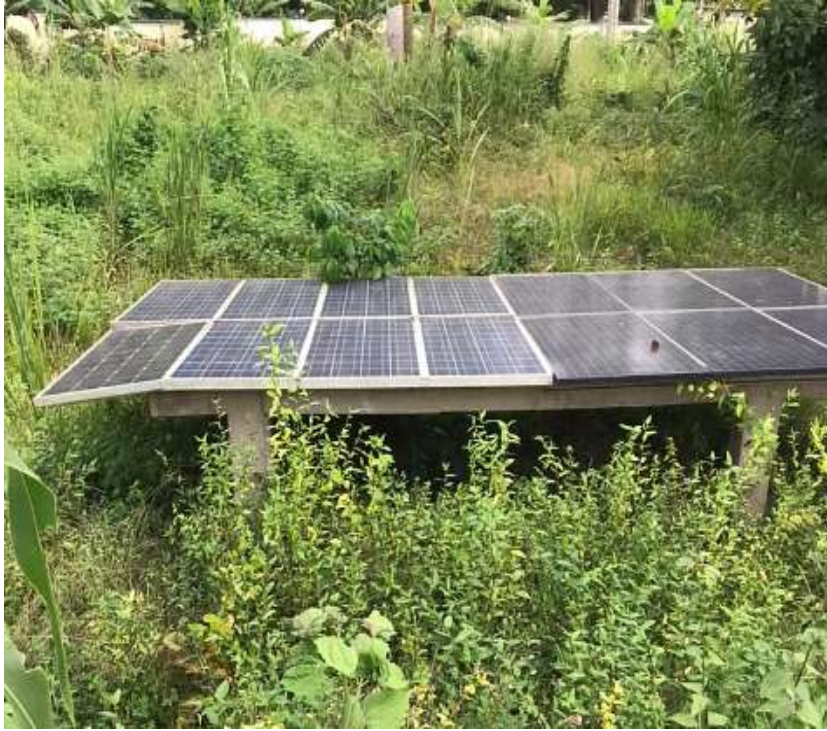
Image 2 : Première installation solaire d'une habitation
