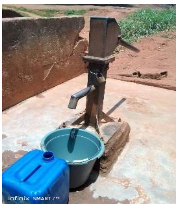
Photo 1: Exemples de forage en usage à Nkol ka’a
