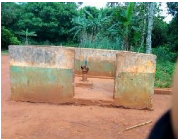
Photo 13: Forage construit par l'ONG ADRA à Nyamvoudou
