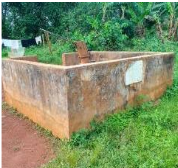
Photo 10 : Forage construit par Guinness-Cameroun et GIZ à Tome
