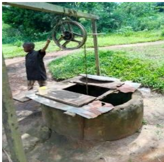
Photo 3: Puits semi-moderne à Bekoungou
