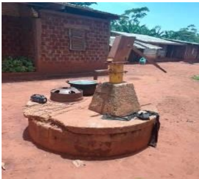
Photo 5: Forage construit par l'UNICEF à Nyamvoudou
