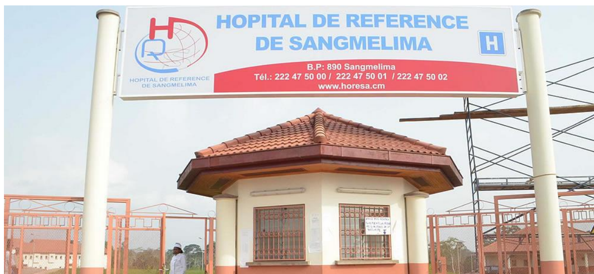
Photo 9 : Façade de l'hôpital de référence de Sangmelima
