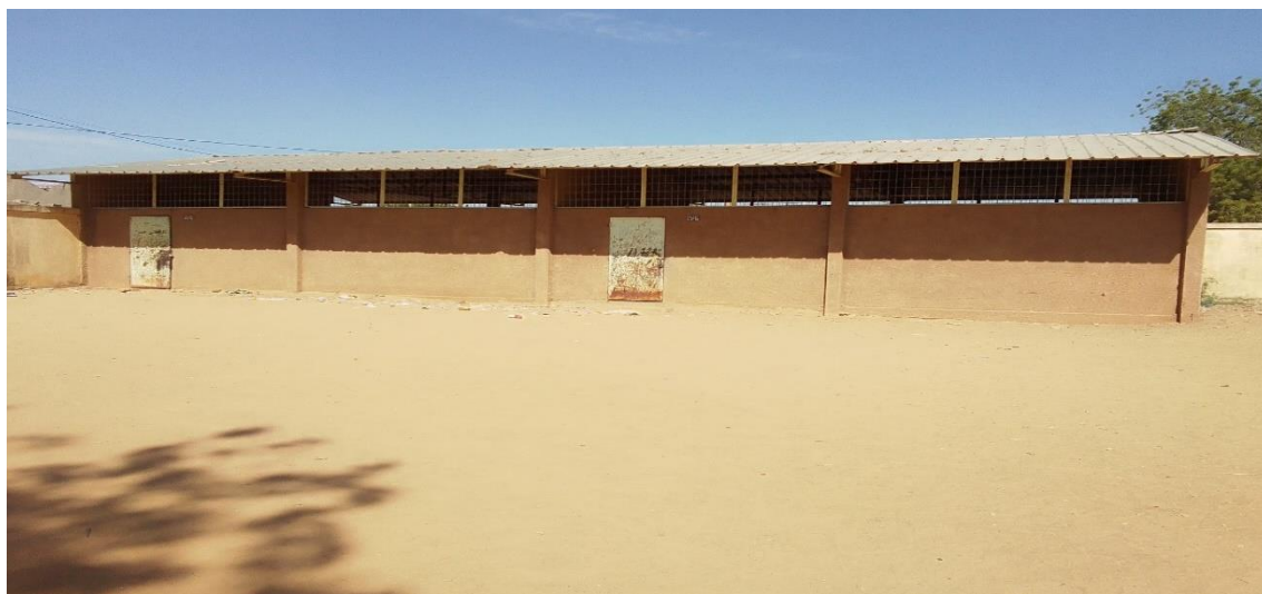
Photo N° 7 : L'école pilote associé de Walia A construite dans l'année 2010.
