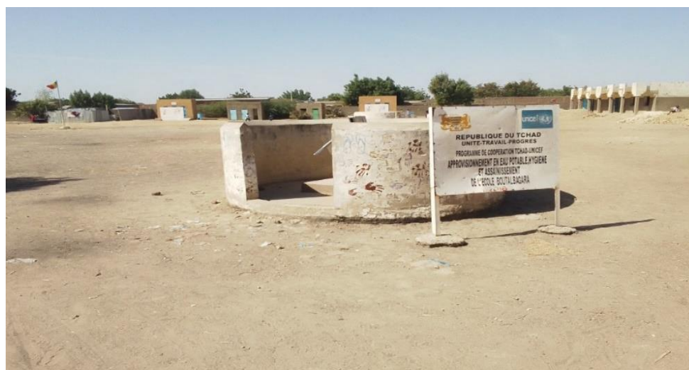
Photo N° 10 : Forage réalisé par l'UNICEF dans l'école primaire Boutalbagar
