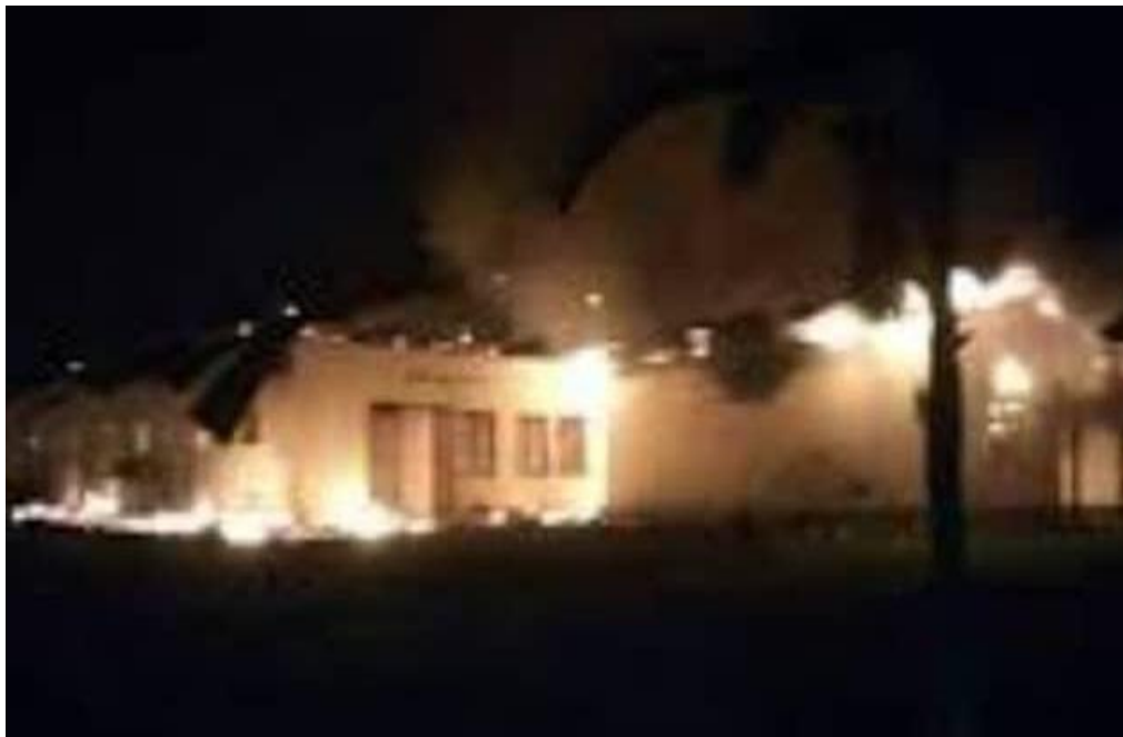
Photo 3 : Hôpital de Tourou en feu.
