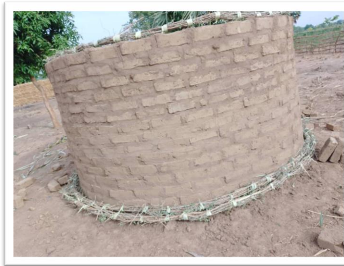
Photo 27: Élévation du mur
