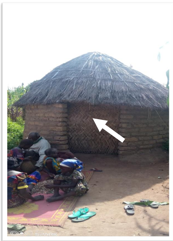
Photo 30: Porte soutenue par deux bois fixés à l'intérieur
