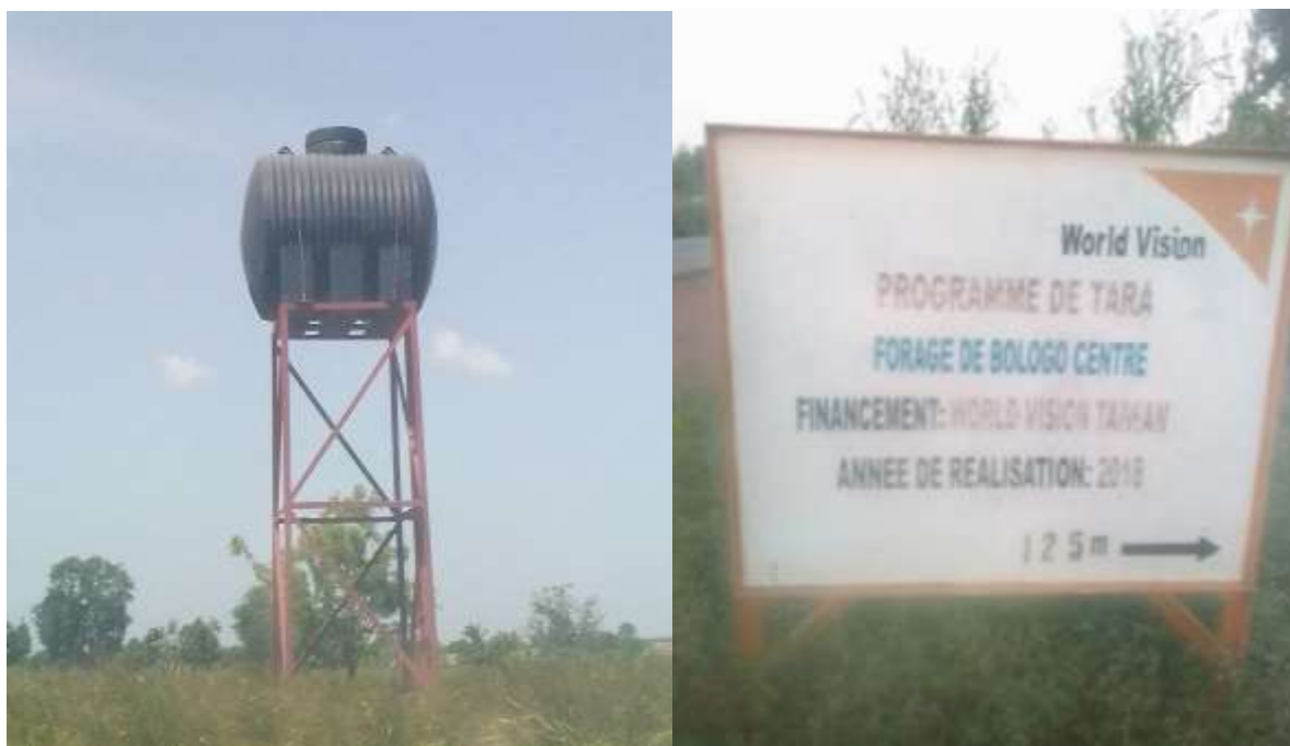
Photo 7 : Château d'eau réalisé par WVT à Bologo
