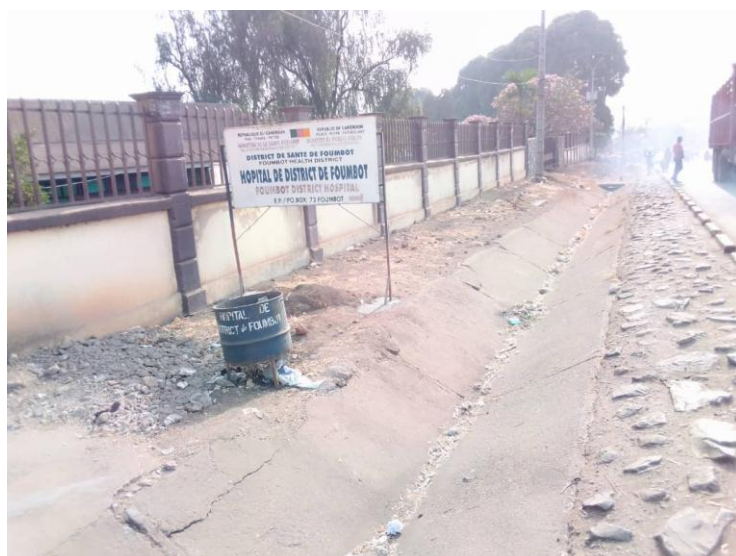
Photo n°1 : Mur et plaque de l'hôpital de district de Foubot Source : NCHARE NJIFON Patrice Didier
