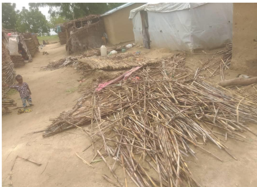
Photo 18: Construction de 1500 abris familiaux
