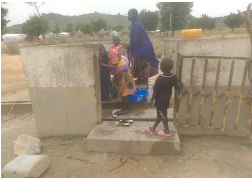
Photo 13: Construction des points d'eau à Zamai
