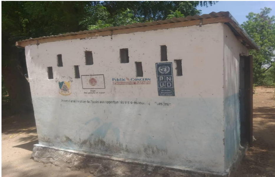
Photo 2: Toilettes construites par Public Concern, Une ONG locale
