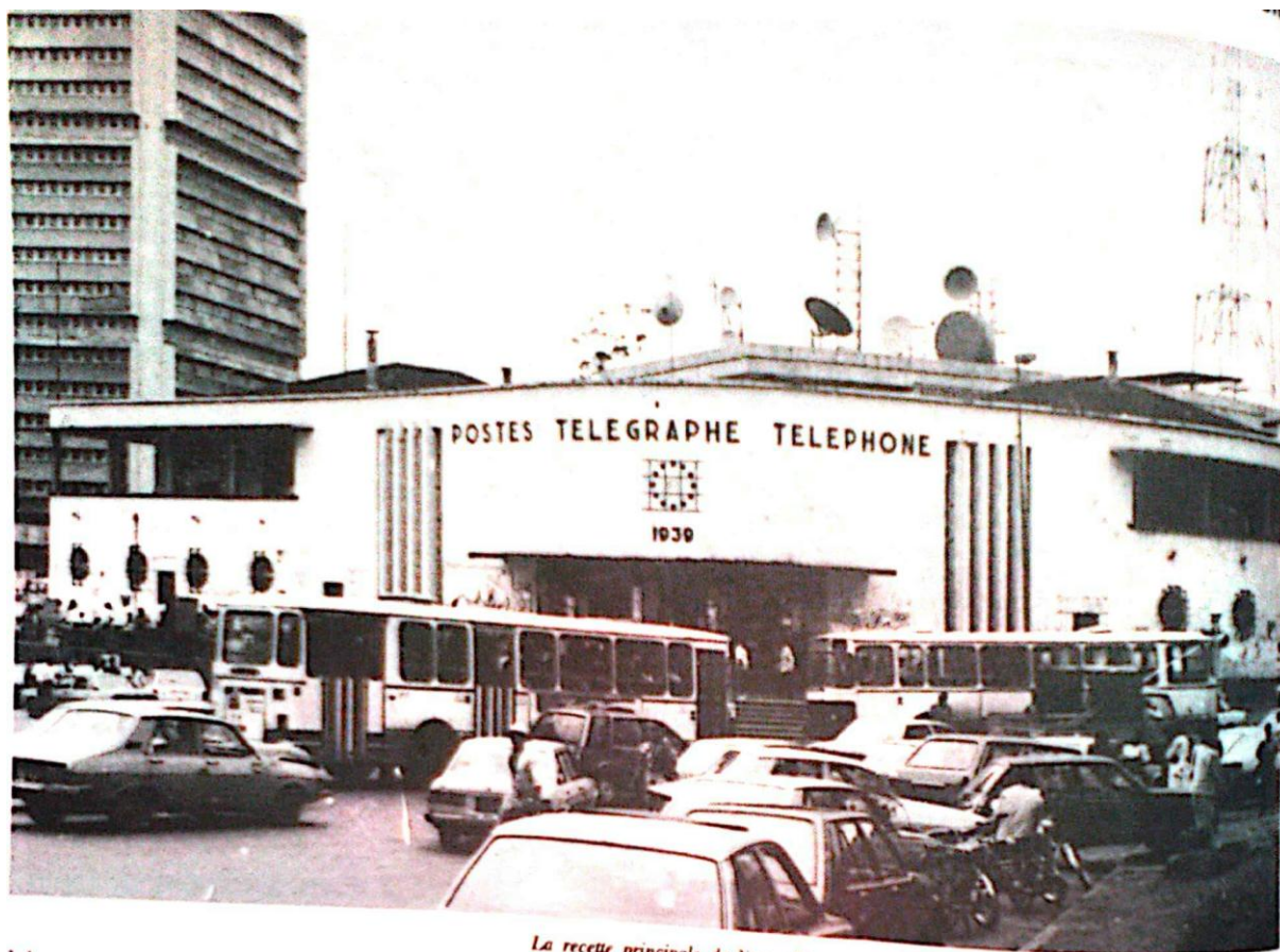
Photo 6 : Poste centrale à Yaoundé
