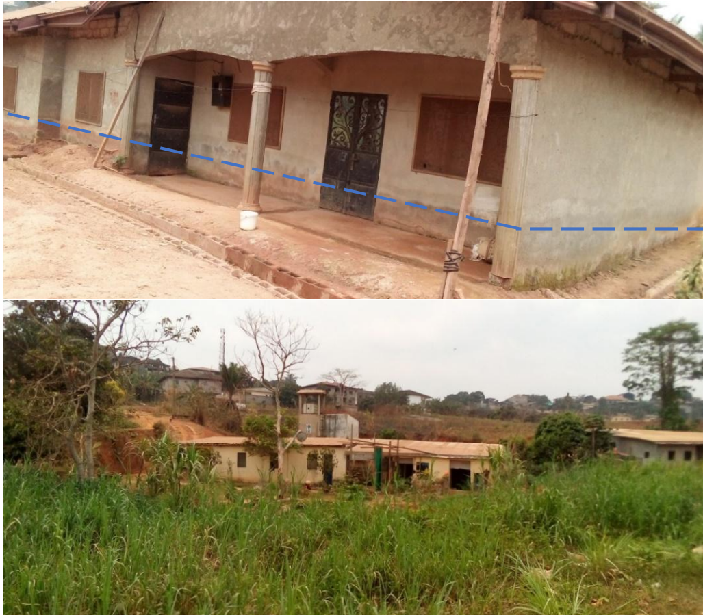
Figure 19 : Exemples de quelques maisons présentant des laisses de crues dans le quartier Ahala II (Cliché Nsangou, 2020)
