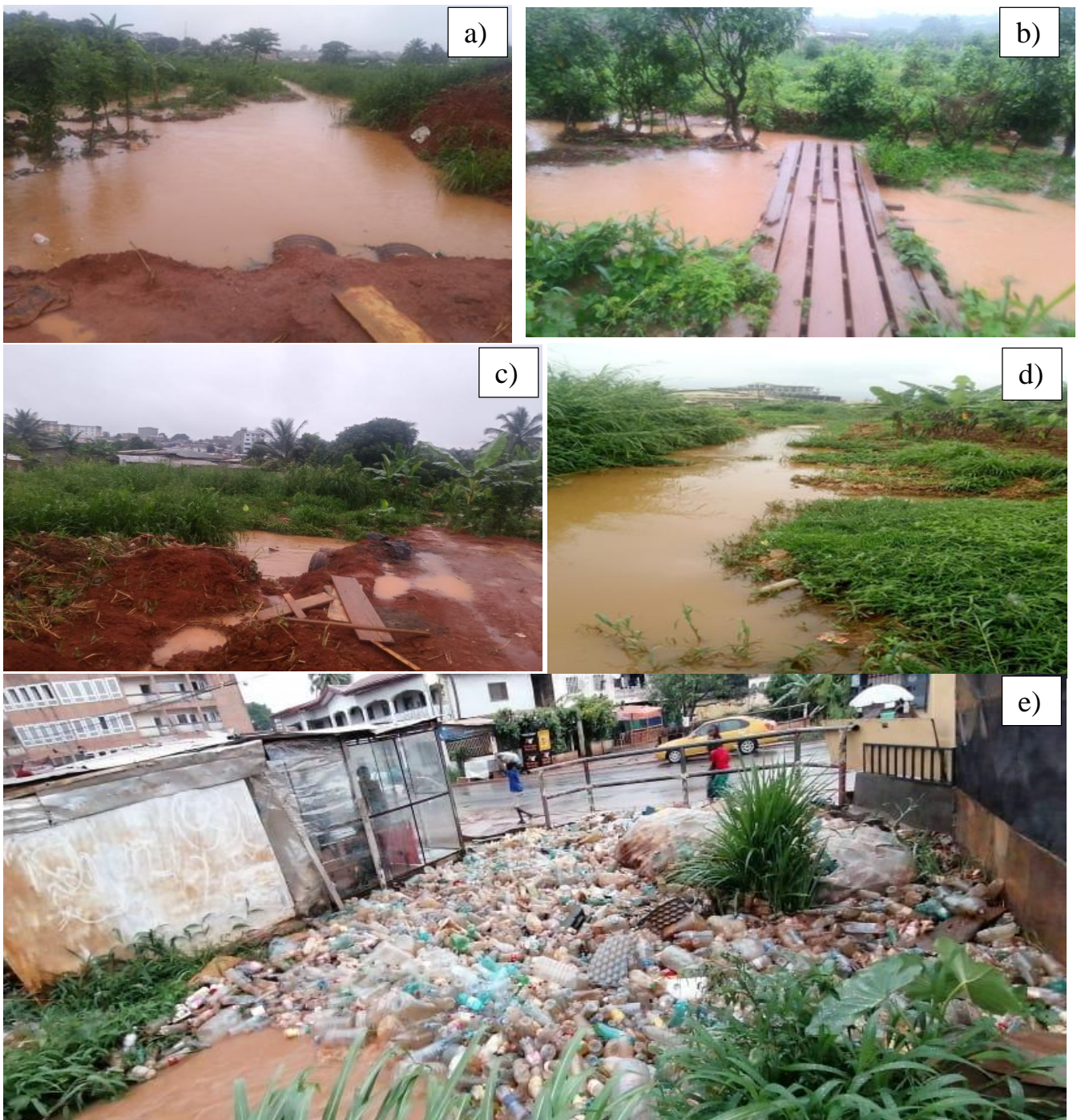
Figure 68: Quelques activités anthropiques qui favorisent l'apparition des inondations dans le bassin versant du Mfoundi : a), b) et c) ouvrages sous-dimensionnés ; d) occupation des zones marécageuses ; e) rejet des déchets urbains dans le lit du cours d'eau ( Cliché Nsangou, 2021 )
