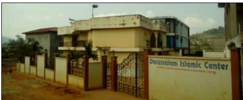
Photo N°48 : Façade principale du complexe scolaire islamique Bista.
