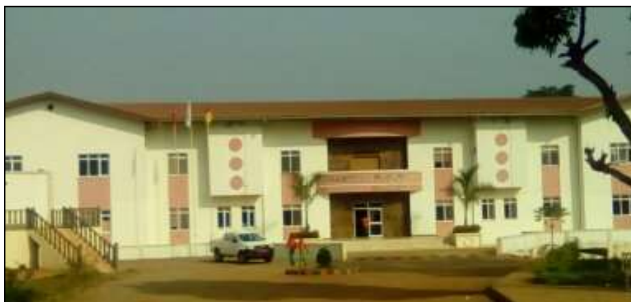
Photo N° 47 : Cour intérieure du collège Adana-Yaoundé.
