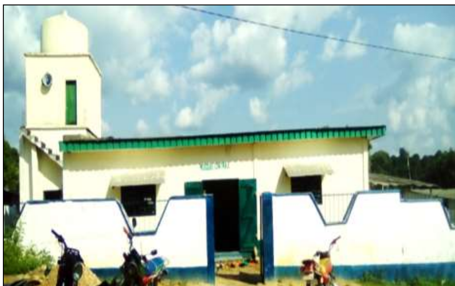
Photo N°17: Mosquée centrale de Monatélé.
