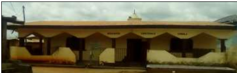
Photo N° 13: Mosquée centrale d'Obala.
