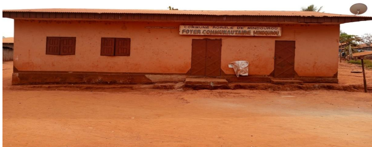
Photo n° 23 : Vue du foyer communautaire de Mindourou construit par la Mairie en 2004
