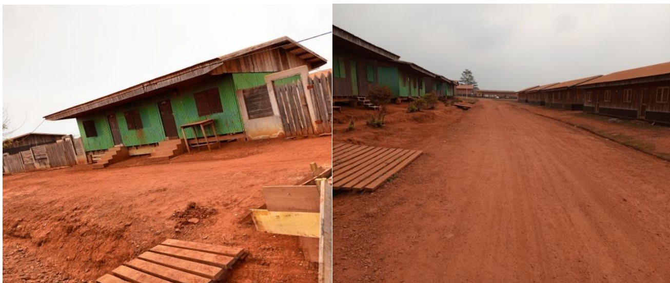
Photo n° 25 : Maisons des ouvriers de la Pallisco construites en matériaux provisoires
