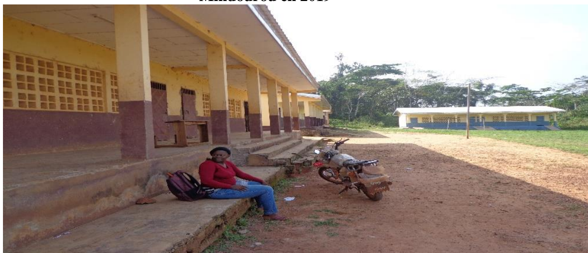
Photo n° 15 : Vue de quelques salles de classes construites par la mairie au lycée de Mindourou en 2019
