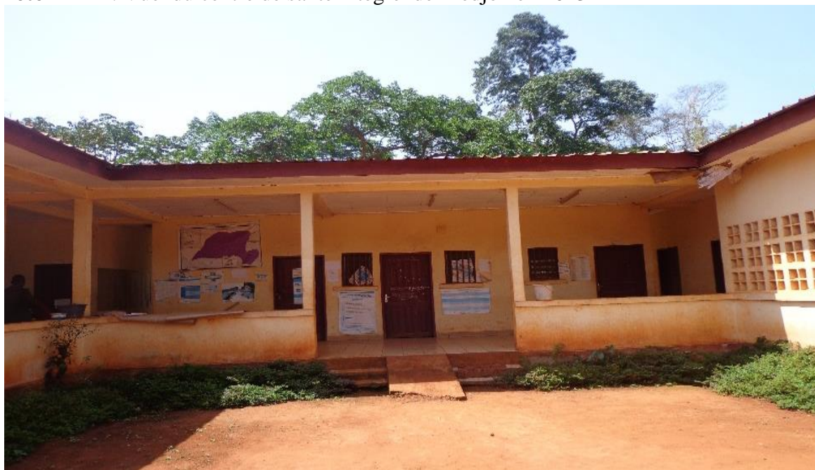
Photo n° 17 : Vue du centre de santé intégré de Medjoh en 2023
