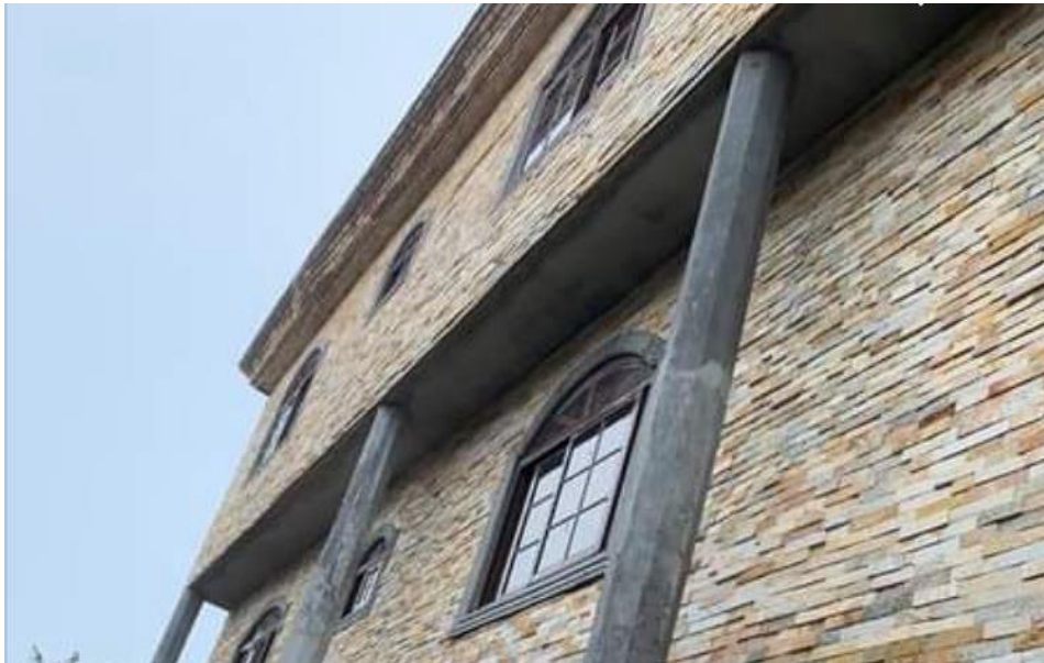
Figure I-14. Revêtement d'un pan de mur en pierre
