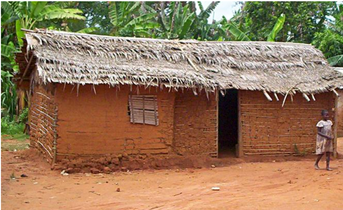
Figure I-8. Technique de mise en œuvre du torchis
