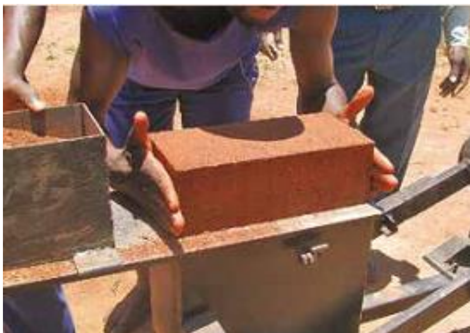
Figure I-10. Mise en œuvre de la brique de terre comprimée
