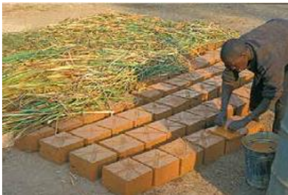
Figure I-9. Mise en œuvre de l'adobe
