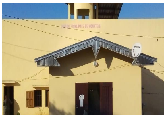
(B) après la rénovation de 2016
