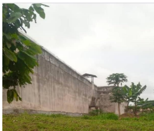
(B) Mur d'enceinte de la PPB
