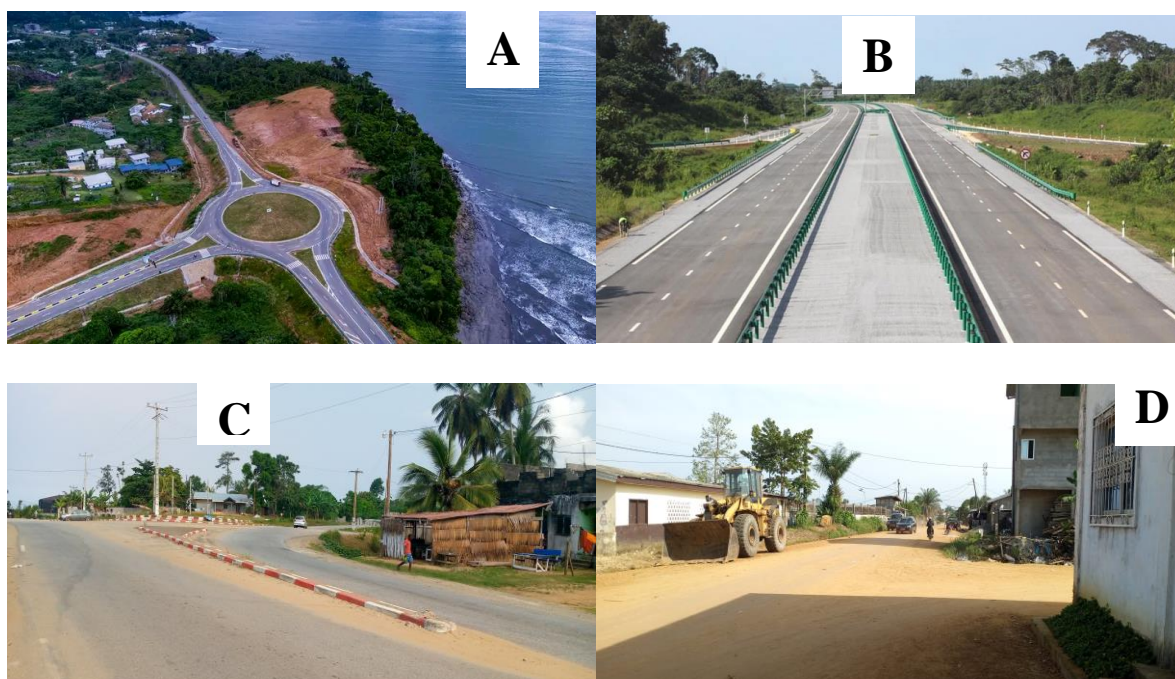
Planche Photographique 10: Vue du réseau viaire de la ville
