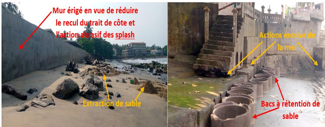
Planche Photographique 15 : Illustration de protection des infrastructures à proximité de la mer dans la zone de Ngoyè-Palm Beach Clichés: UM II Paul 2022
