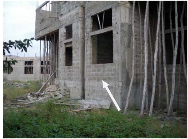
Photo 20 : Un bâtiment en construction à Ayélawadjè (Akpakpa) Cliché : GNELE (2009)
