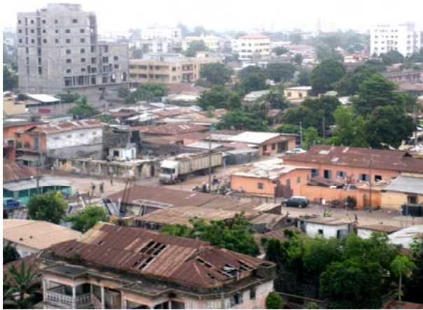
Photo 7 : Aperçu de la mutation progressive de la ville dans un ancien quartier (Gbété) Cliché : GNELE (2009)
