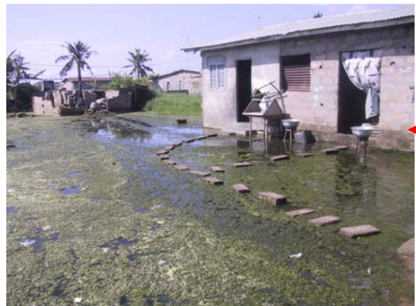
Photo 4 : Etat des maisons après le retrait des eaux dans le quartier Ladji Cliché : GNELE (2007)
