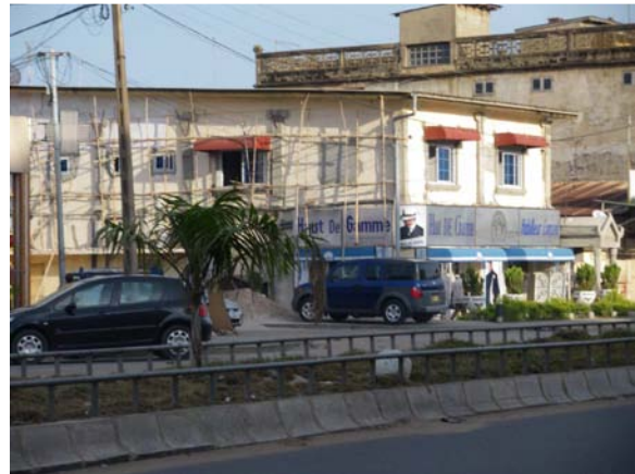
Photo 8 : Aperçu de vieux bâtiments en cours de réaménagement (Avenue Steinmetz) Cliché : GNELE (2009)
