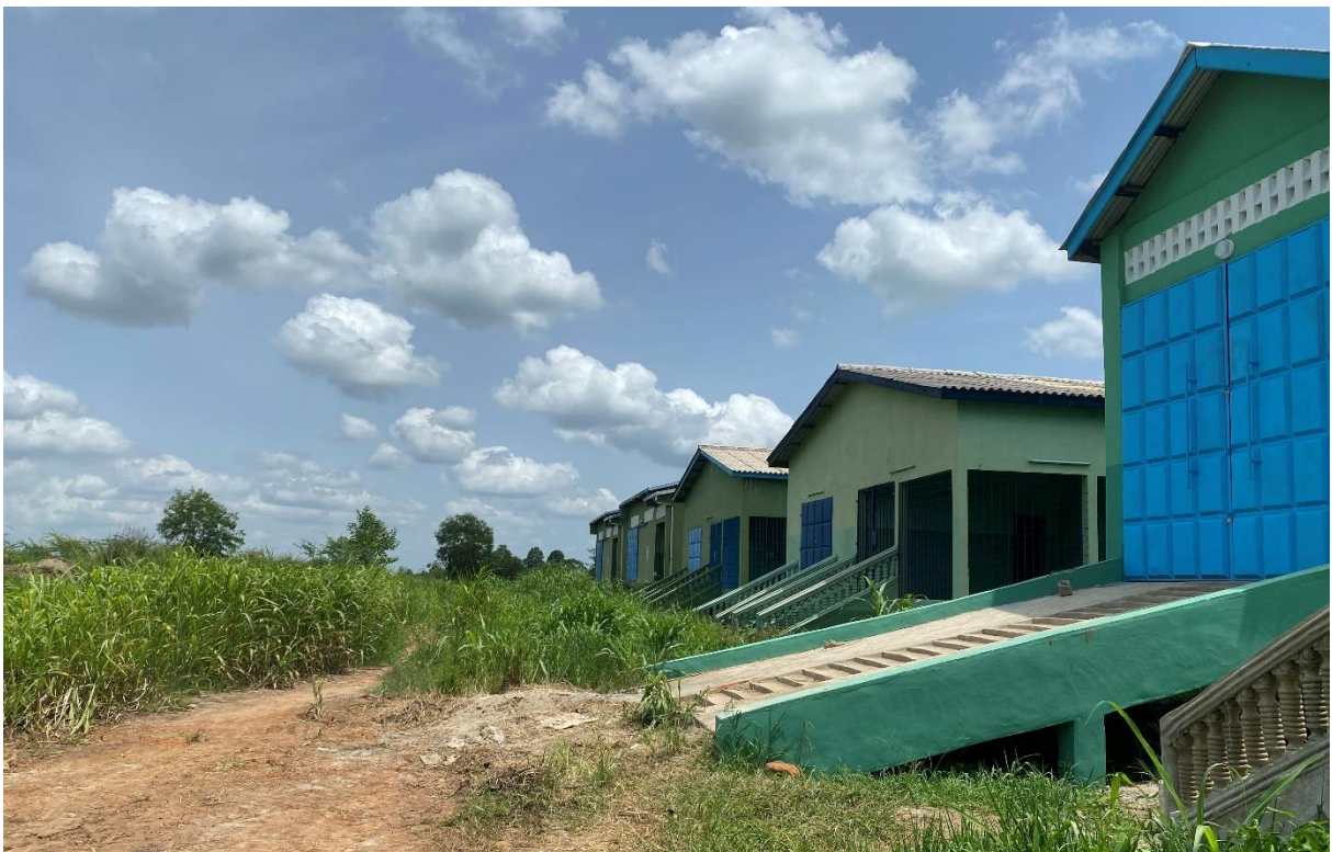
Photo 4 : Magasin de stockage de Hlankpa
