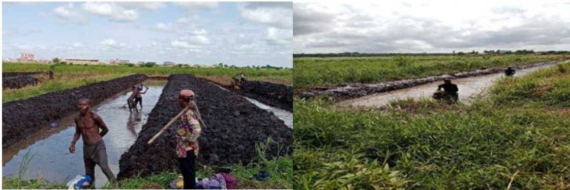
Photo 7 : Réalisation des planches surélevée et curage des drains existants à Hozin
