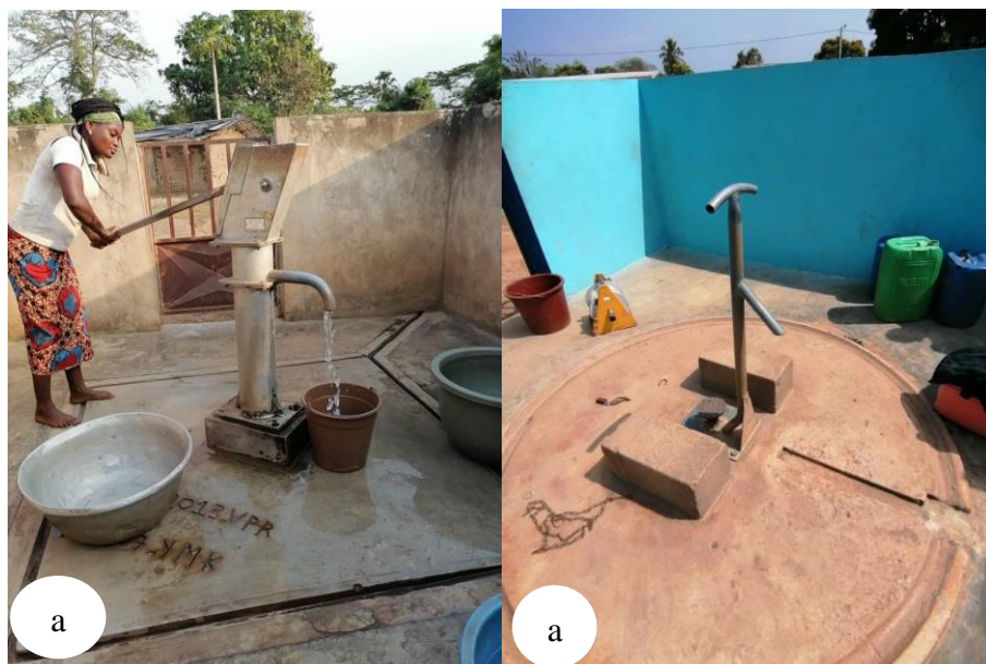
Figure 58: Pompe à motricité humaine a : Pompe à motricité humaine de marque ABY à Amanidjekro (S/P Yamoussoukro), b : Pompe à motricité humaine de marque Vergnet à Totonou (S/P Toumodi)
