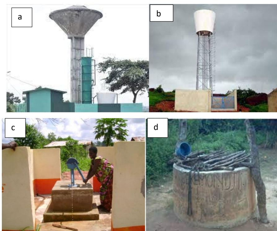
Figure 5 : Ouvrages d'approvisionnement en eau
