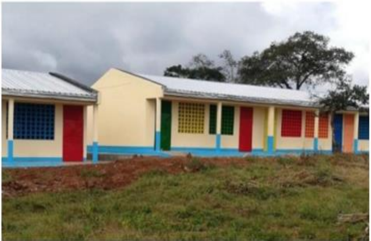
Photo 4,5&6 : projets de construction réalisés par le UNHCR
