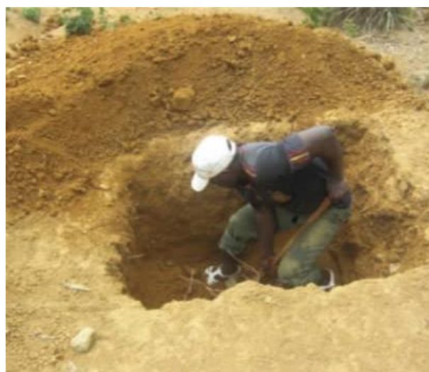
Figure 6. Puits de reconnaissance à proximité de la ville de Mamfé sur argilites.
