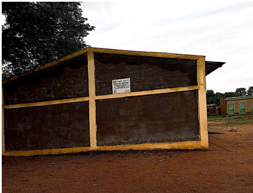
2- Côté gauche du bâtiment de l'école primaire publique construite par le projet/PAQEPP, filmé en Aout 2022 dans la Commune de Moundou par NADDJIDJIM Ndoroum Aaron
