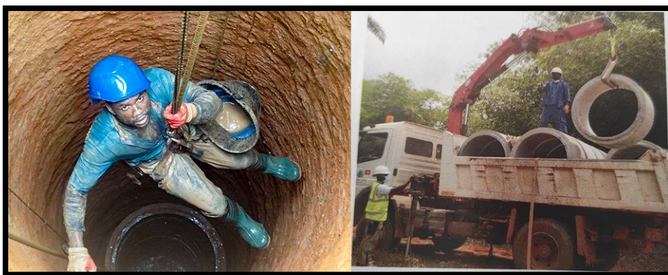
Photo 8 : Un puisatier et un camion chargé d'apporter les buses sur le site de construction du puits
