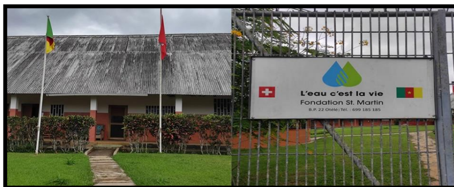
Photo 4 : Vue de face des locaux administratifs de la FSMO à Otélé
