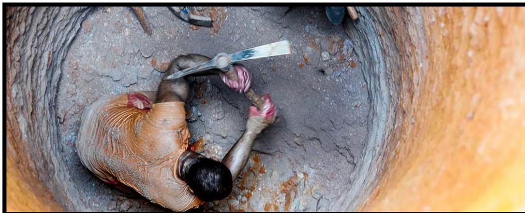
Photo 17 : Une vue du creusage d'un puits
