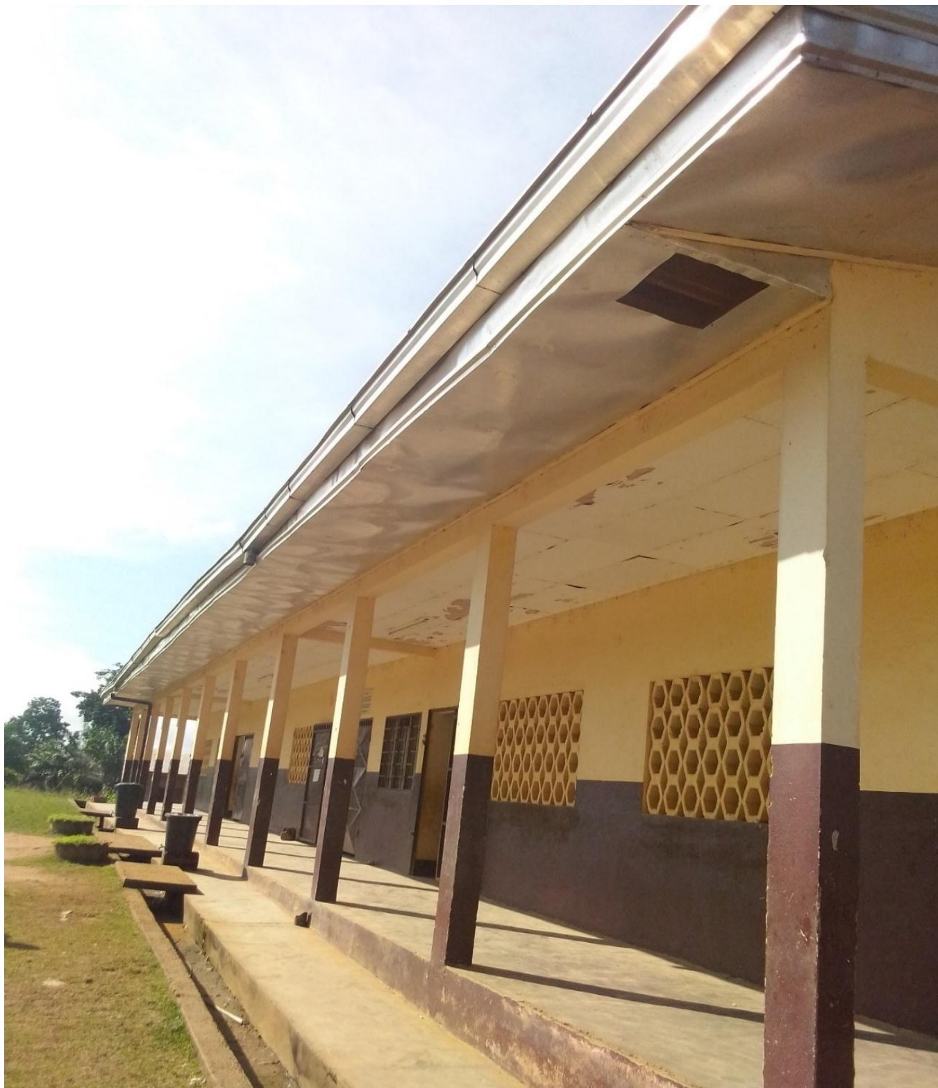
Photo 3 : Bâtiment de trois salles de classe construit par la société coopérative Mbangas sud COOP-CA à l'école publique de Biakoa en 2015.
