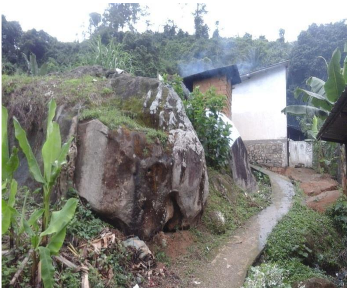
Photo 2 : Occupation des zones à risque au quartier New-Bell village à Ebolowa.
