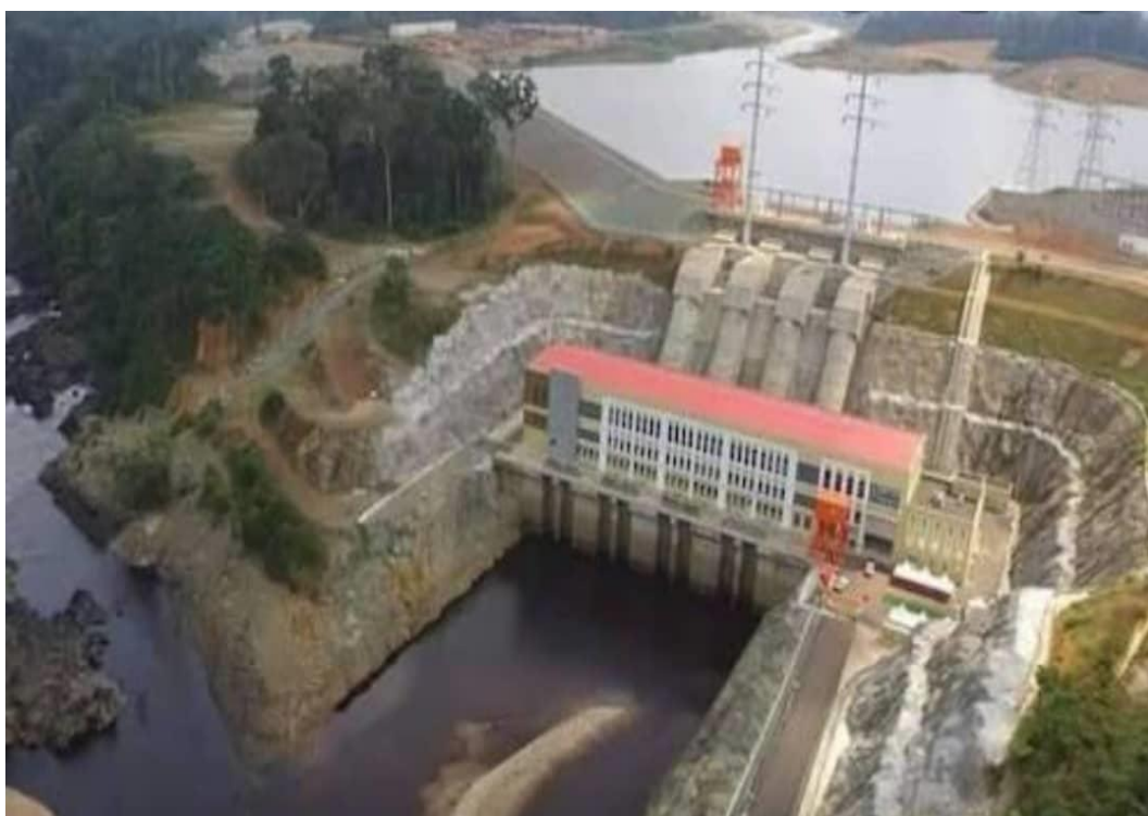
Photo 17 : Barrage hydro-électrique de Memve'ele
