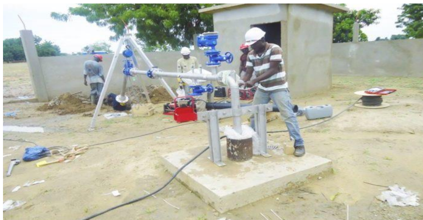
Photo 14 : Réalisation du forage à Laiï
