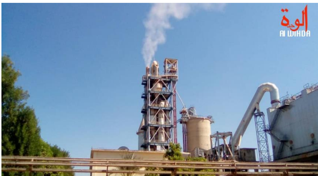
Photo 3 : image de la cimenterie de Baoré.
