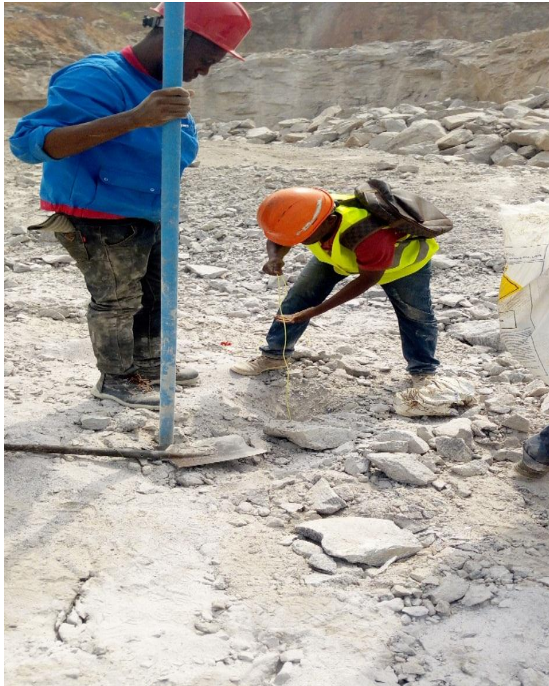
Figure II-3. Operations de chargement et d'amorçage.
