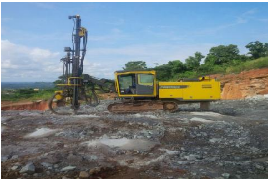
Figure II-2. Foration sur la plateforme de tir.
