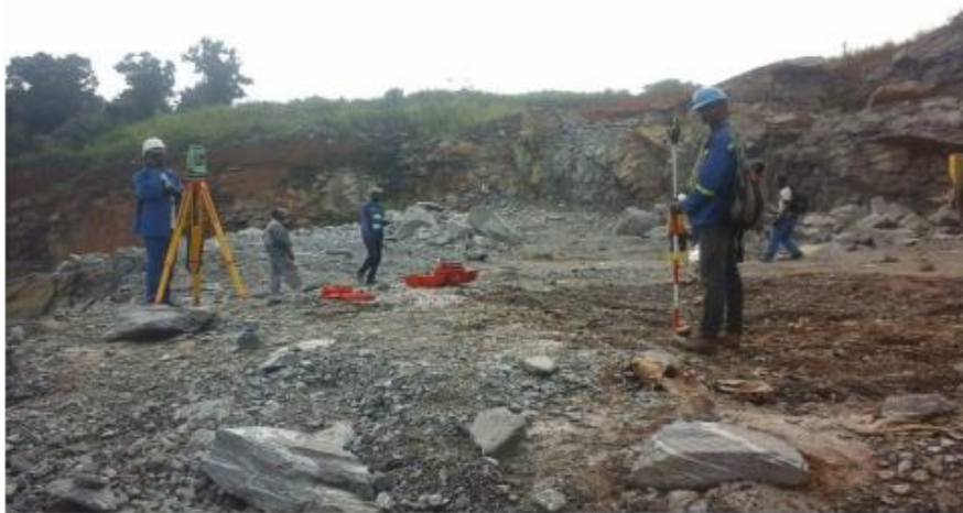
Figure II-1. Implantation des trous de forage.
