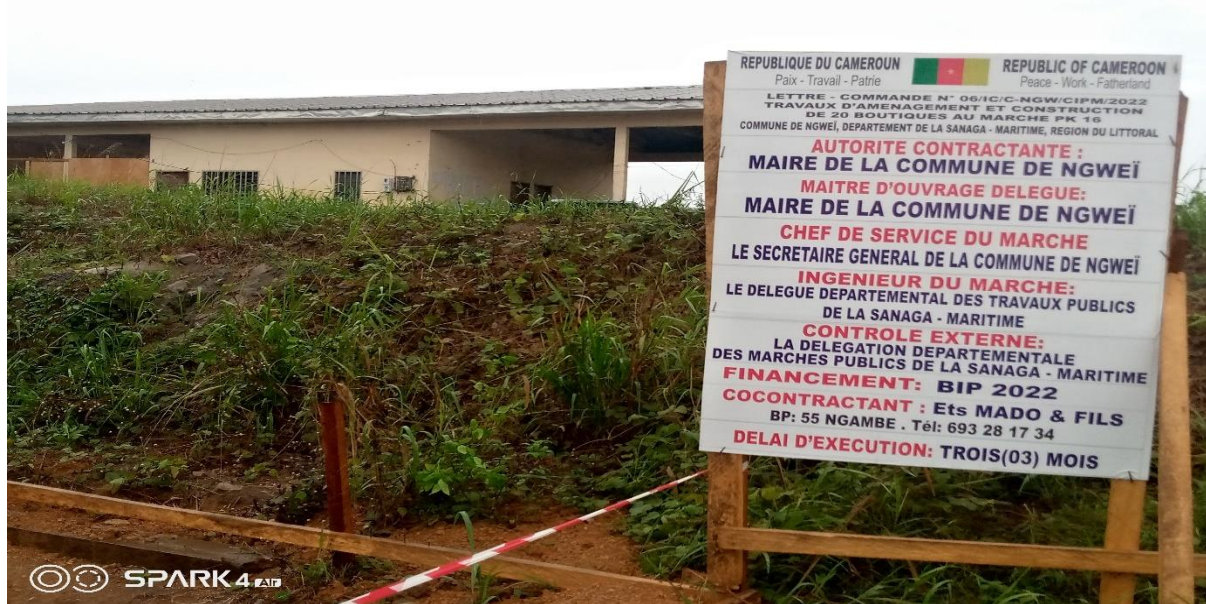
Photo 9: Hangar de Marché
