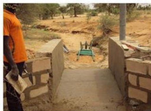
Section de mesure en construction
