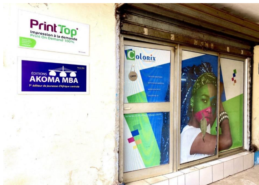
Vue d'entrée de l'immeuble avec au rez-de-chaussée l'imprimerie Colorix
