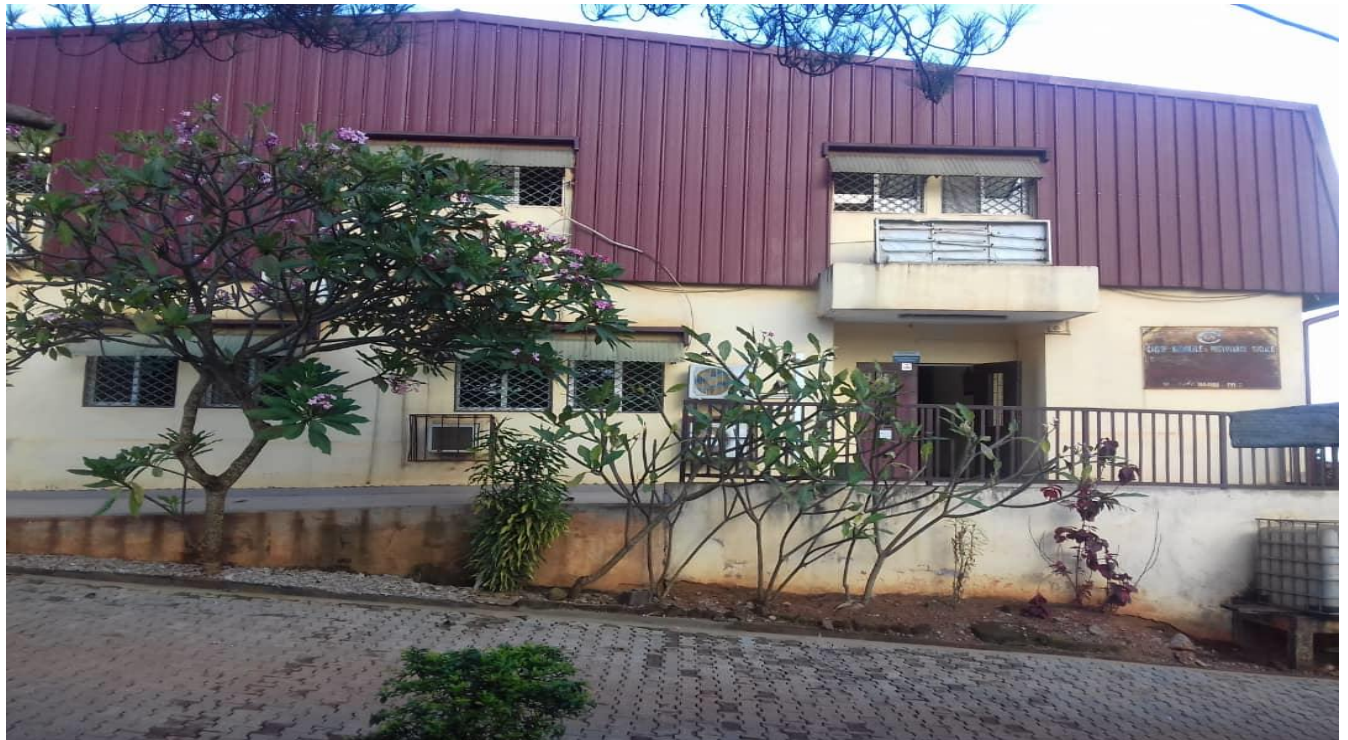
Vue de face d bâtiment A
