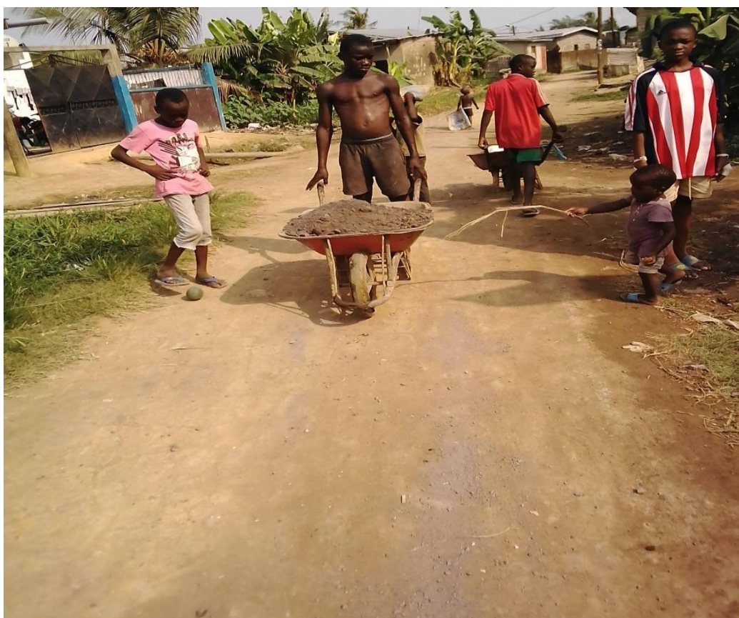
Photo 8: Technique de remblaiement des routes
