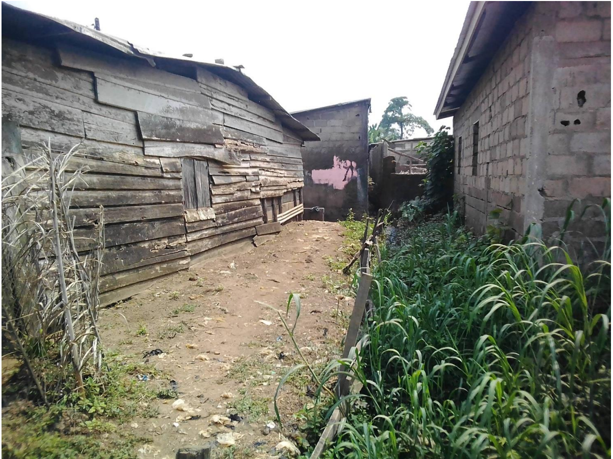
Photo 10: habitats construits sur les drains
