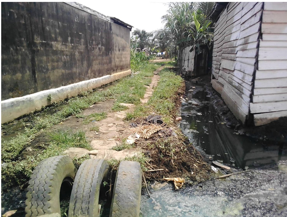
Photo 5: Une maison entourée d'eau usée noirâtre
