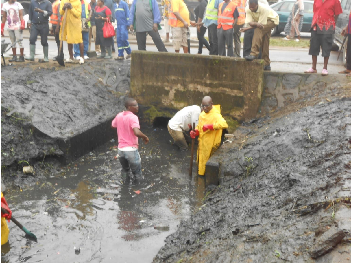
Photo 9: Curage des drains par la mairie
