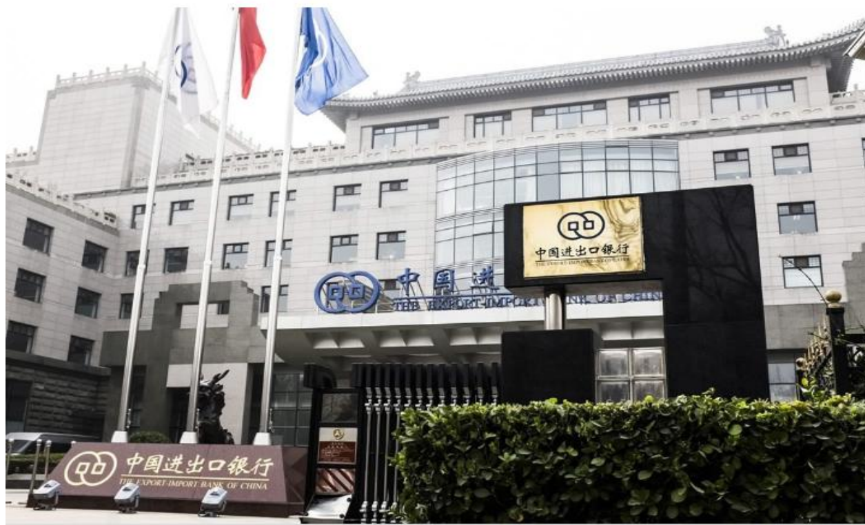
Photo n° 3 : Succursale de Pékin, la banque d'exportation-importation de Chine/photo VCG (Visual China Group)
