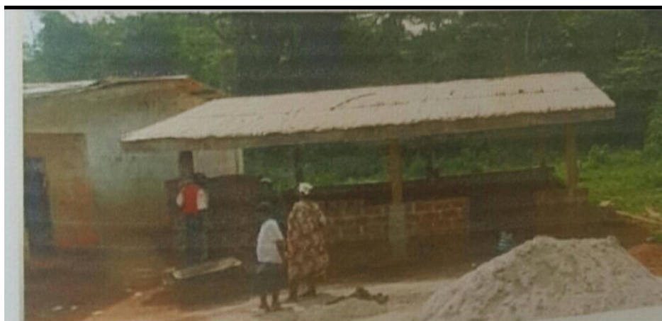
Photo 5: Une salle de classe en chantier : œuvre social du GIC Welekamel à Mbangué en 2010.
