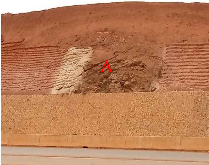
Photo A : vue d'une roche sur l'un des talus de l'autoroute au quartier Meyo
