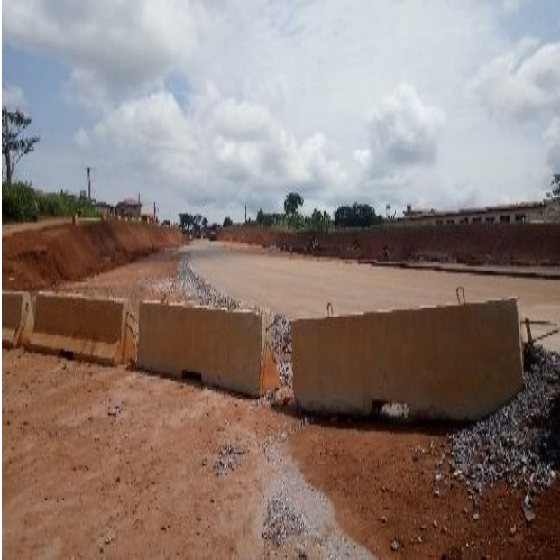
Photo A : travaux de terrassement au quartier Meyo
