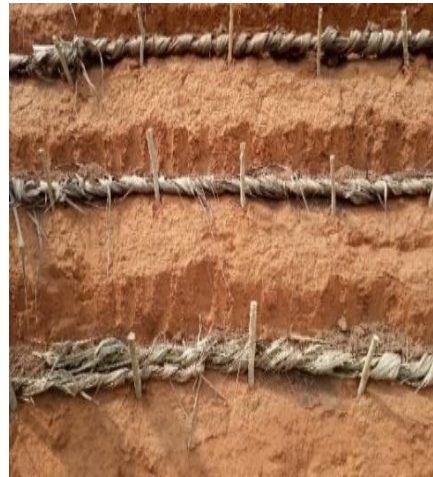
Photo B : fascines disposées sur les redans creusés
