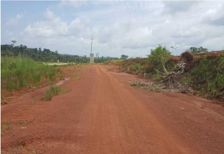
Photo A : abattage d'arbres pour la construction de l'autoroute Yaoundé-Nsimalen au niveau de Nsimalen.
