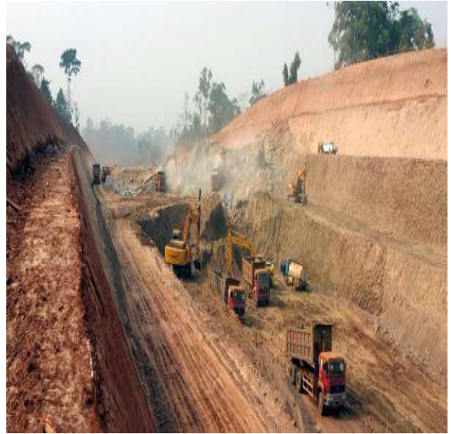
Photo B : Travaux de terrassement pour l'implantation de l'autoroute Yaoundé-Nsimalen
