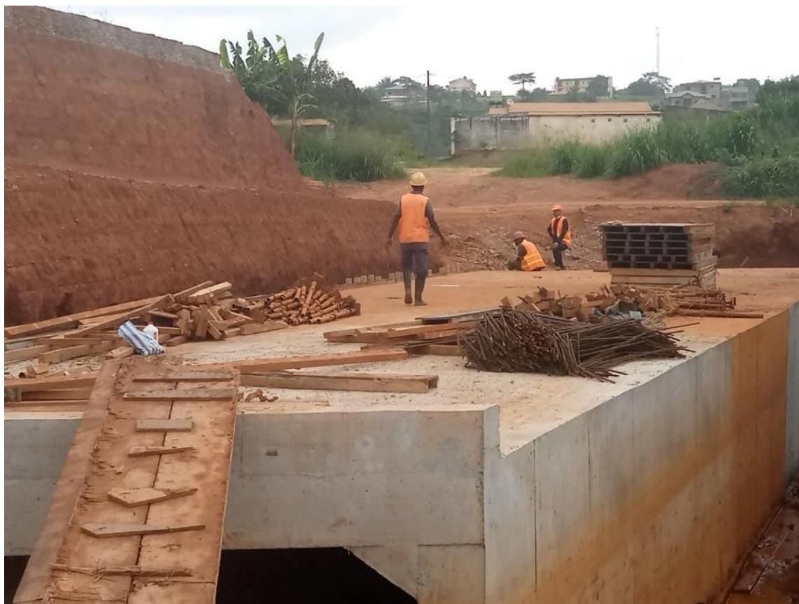
Photo 4 : Une batterie de dalots 3X (3mx3m) + 6X (4mx3m) +3X (4mX3m) sur la rivière du Mfoundi
