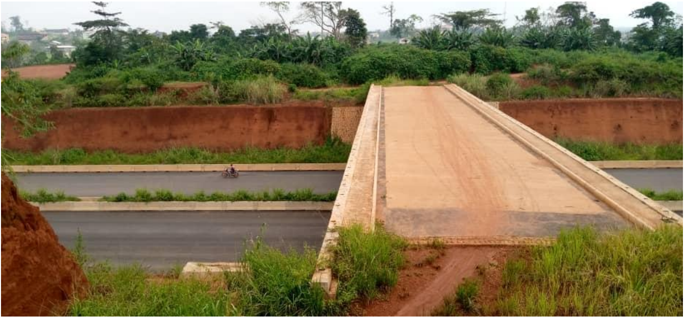
Photo 3 : Rétablissement de toutouli en passage supérieur au PK3+565
