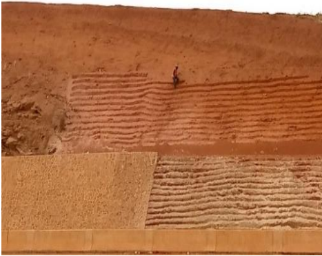
Photo A : ouvrier creusant les redans sur l'un des talus de l'autoroute
