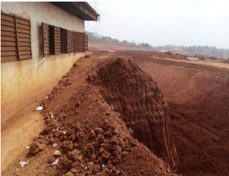
Photo C : Travaux de terrassement au niveau de l'école publique de Meyo
