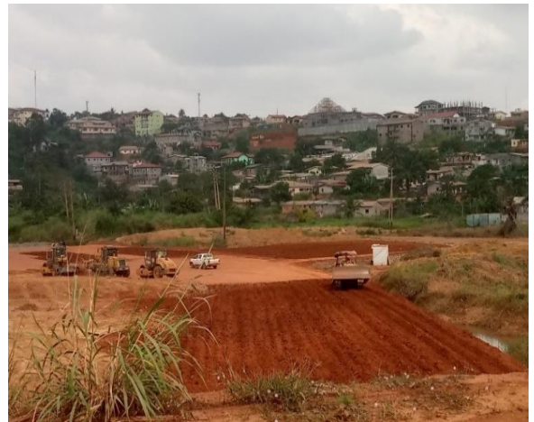
Photo B : remblaiement de la zone marécageuse d'Ahala
