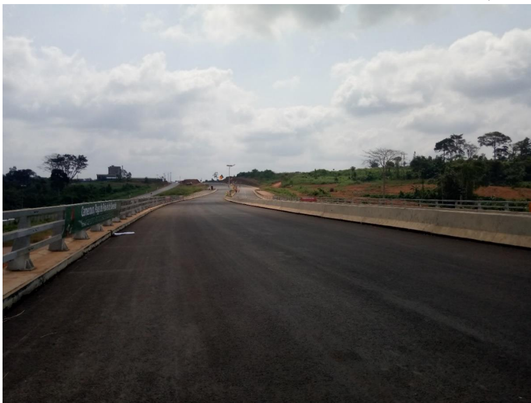
Photo 1 : vue d'une partie de la chaussée de l'autoroute Yaoundé-Nsimalen
