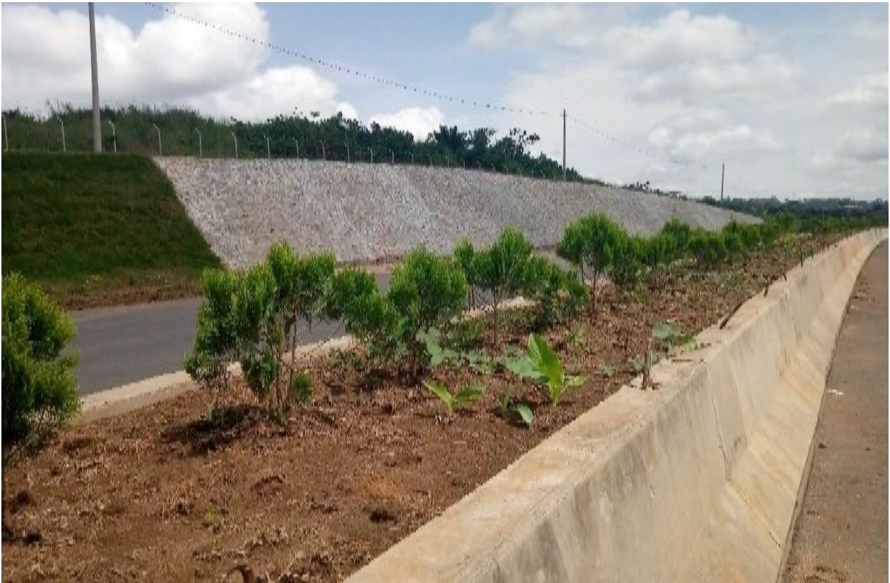
Photo 11 : aperçu de la grille métallique de protection
