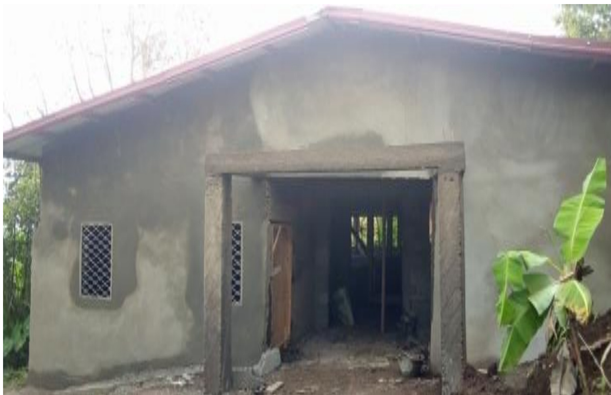
Photo 6: Bâtiment de production du GIC Tah-Tchouo de Bafoussam
