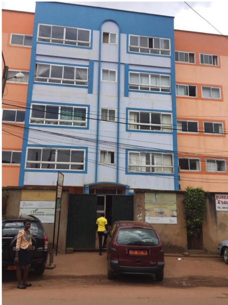
Vue de l'immeuble Steve Biko, source : Danielle Ndjotta
