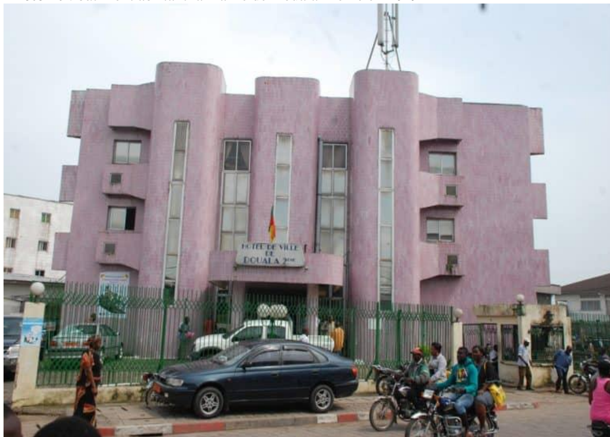
Photo 10 : bâtiment abritant la mairie de Douala II ème en 2019
