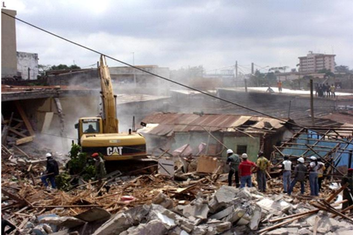
Photo 7 : Opérations de déguerpissement en cours à Briqueterie Est.
