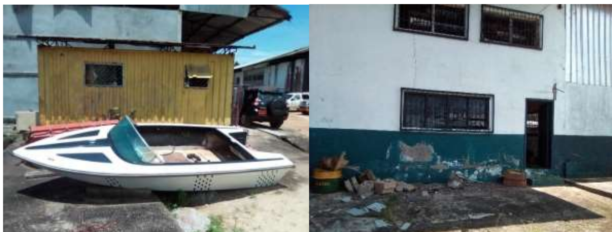
Photo 10 : Magasin et entrepôt du port de Kribi
