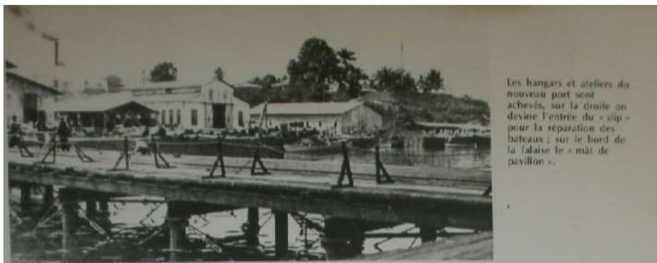
Photo 4: Hangars et ateliers du port de Douala sous le protectorat
