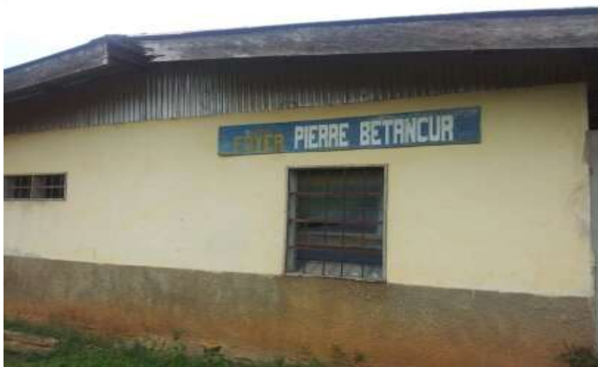
Photo 21: Foyer Pierre Bétancur construit en 1969
