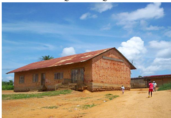
MAISON EN BRIQUE AU QUARTIER ODIN
