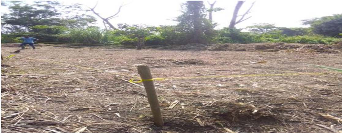
Figure4. Piquetage du site
