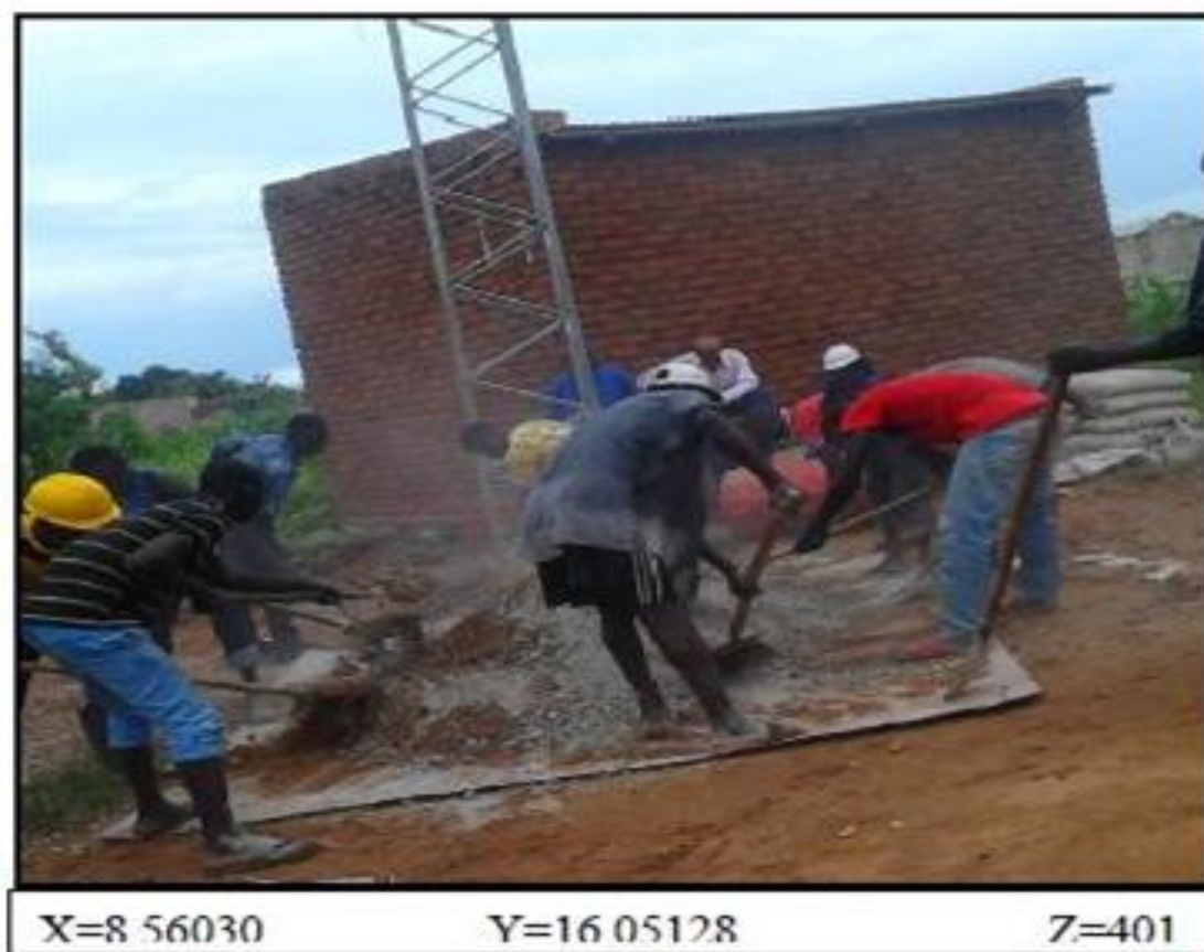
Photo 5: Implantation d'un pylône HT à Dokab
