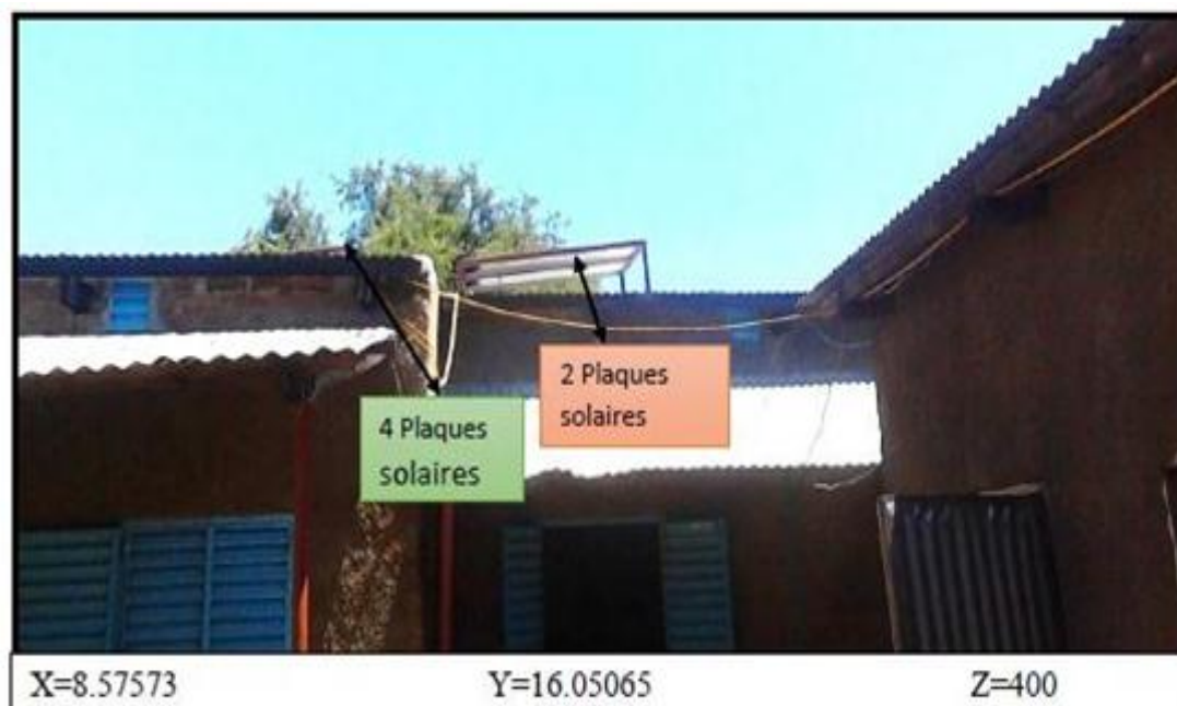
Photo 2: Plaque solaire installée sur le toit de maison
