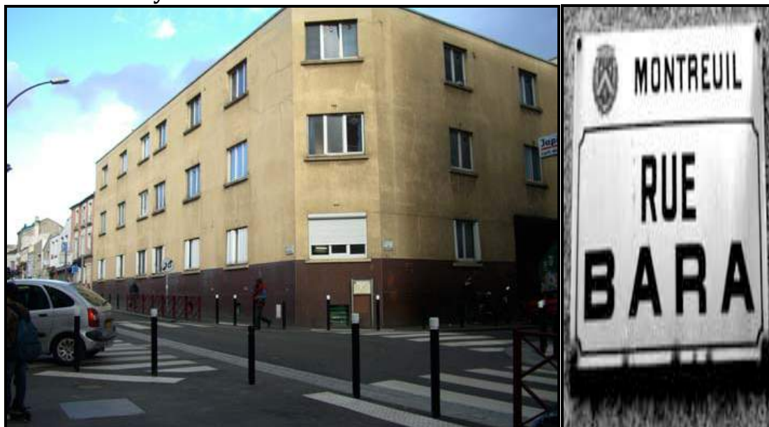
Photo 3 : Le Foyer Bara et sa rue
